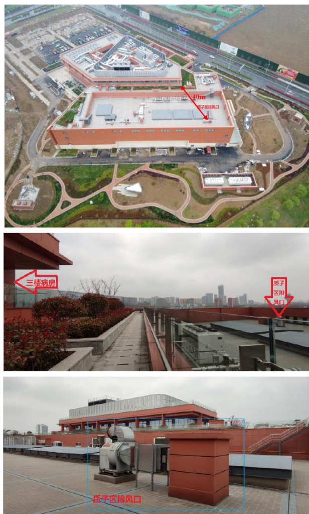
图 4-41 本项目典型场所的质子区排风口现场照片
